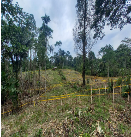
Foto: Levantamiento topográfico y replanteo del área destinada para la casa de semillas en el ISTECS en Sucumbíos
